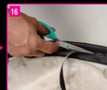
シート裏側を確認し、余った箇所をハサミやカッターナイフでカットします。
